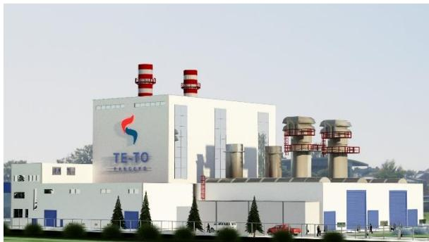
TE-TO Pančevo je prva gasno-parna elektrana u Srbiji, namenjena za kombinovanu proizvodnju električne i toplotne energije na bazi prirodnog gasa, jednog od ekološki najčistijih goriva. Proizvedena toplotna i električna energija koristiće se za potrebe Rafinerije nafte u Pančevu, dok će se višak električne energije prodavati u Srbiji.
