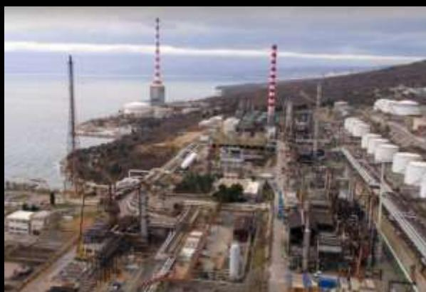
Prerada u riječkoj rafineriji bila je obustavljena od novembra 2022. godine, zbog potrebe za nadogradnjom i povećanjem kapaciteta procesnih jedinica za rekuperaciju sumpora (SRU) i hidrokrekinga (HCU), kako bi se uskladile s novim postrojenjem za obradu teških ostataka.
